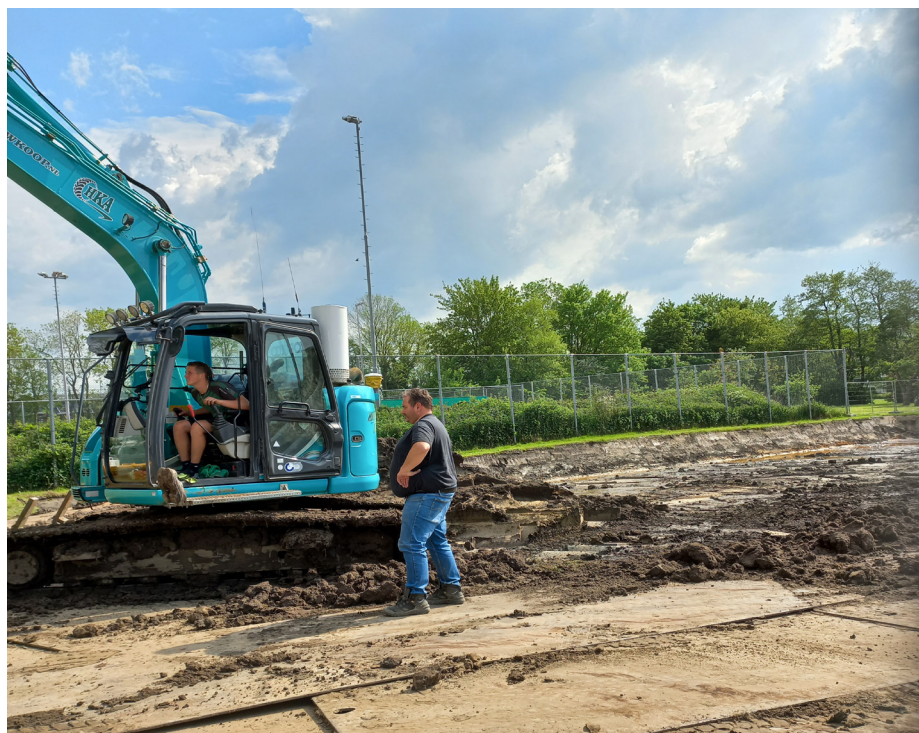
foto: het grondwerk is begonnen
